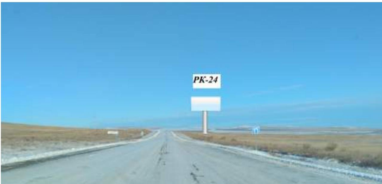
1. Расстояние сбоку от автомобильной дороги на расстоянии от бровки земляного полотна (внешней границы обочины) до ближайшей точки горизонтальной проекции внешнего конструктивного элемента средства наружной рекламы 12 м. Расстояние от перекрестка 350 м.
