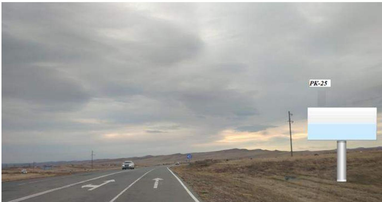
1. Расстояние сбоку от автомобильной дороги на расстоянии от бровки земляного полотна (внешней границы обочины) до ближайшей точки горизонтальной проекции внешнего конструктивного элемента средства наружной рекламы 11,5 м. Расстояние от перекрестка 350 м.
