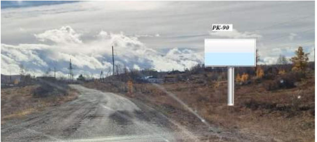
1. Расстояние сбоку от автомобильной дороги на расстоянии от бровки земляного полотна (внешней границы обочины) до ближайшей точки горизонтальной проекции внешнего конструктивного элемента средства наружной рекламы 4 м
