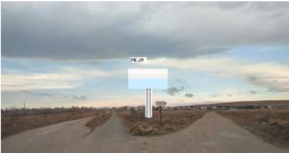
1. Расстояние сбоку от автомобильной дороги на расстоянии от бровки земляного полотна (внешней границы обочины) до ближайшей точки горизонтальной проекции внешнего конструктивного элемента средства наружной рекламы 2 м
