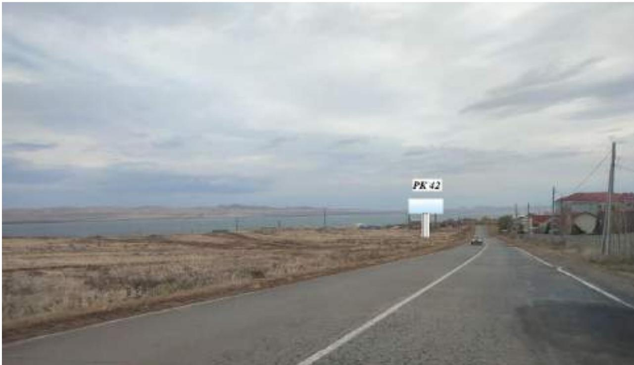
1. Расстояние сбоку от автомобильной дороги на расстоянии от бровки земляного полотна (внешней границы обочины) до ближайшей точки горизонтальной проекции внешнего конструктивного элемента средства наружной рекламы 9 м
