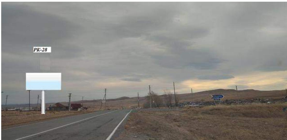
1. Расстояние сбоку от автомобильной дороги на расстоянии от бровки земляного полотна (внешней границы обочины) до ближайшей точки горизонтальной проекции внешнего конструктивного элемента средства наружной рекламы 9 м. Расстояние от перекрестка 350 м.
