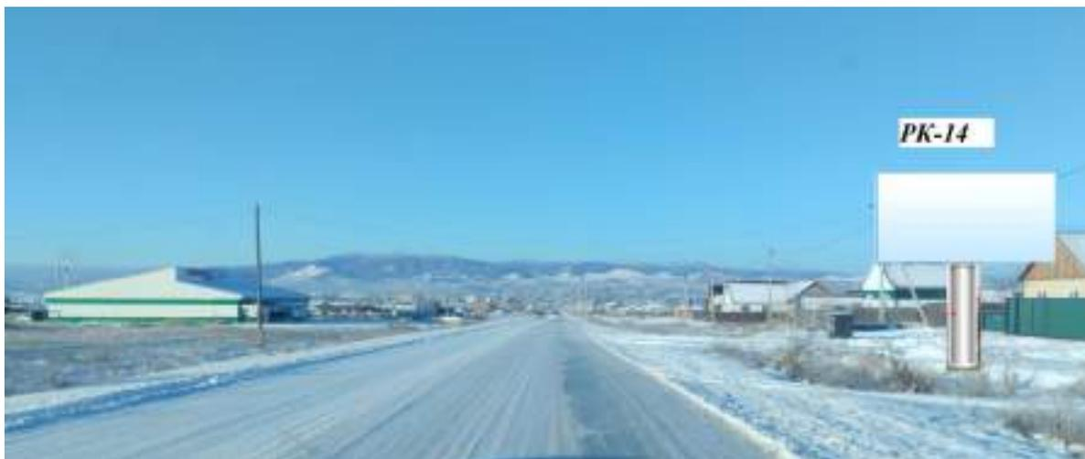
1. Расстояние сбоку от автомобильной дороги на расстоянии от бровки земляного полотна (внешней границы обочины) до ближайшей точки горизонтальной проекции внешнего конструктивного элемента средства наружной рекламы 6 м
