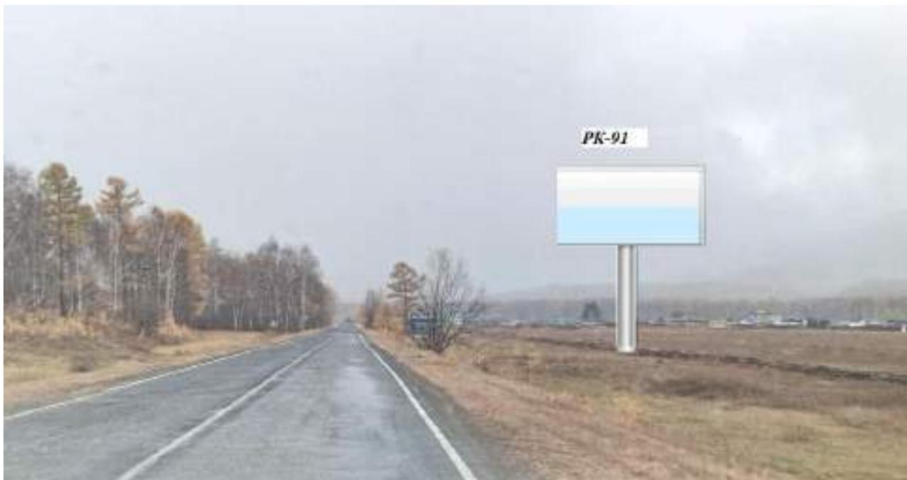
1. Расстояние сбоку от автомобильной дороги на расстоянии от бровки земляного полотна (внешней границы обочины) до ближайшей точки горизонтальной проекции внешнего конструктивного элемента средства наружной рекламы 12 м
