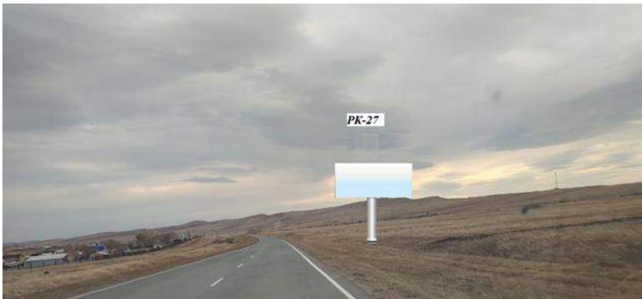
1. Расстояние сбоку от автомобильной дороги на расстоянии от бровки земляного полотна (внешней границы обочины) до ближайшей точки горизонтальной проекции внешнего конструктивного элемента средства наружной рекламы 10 м.
