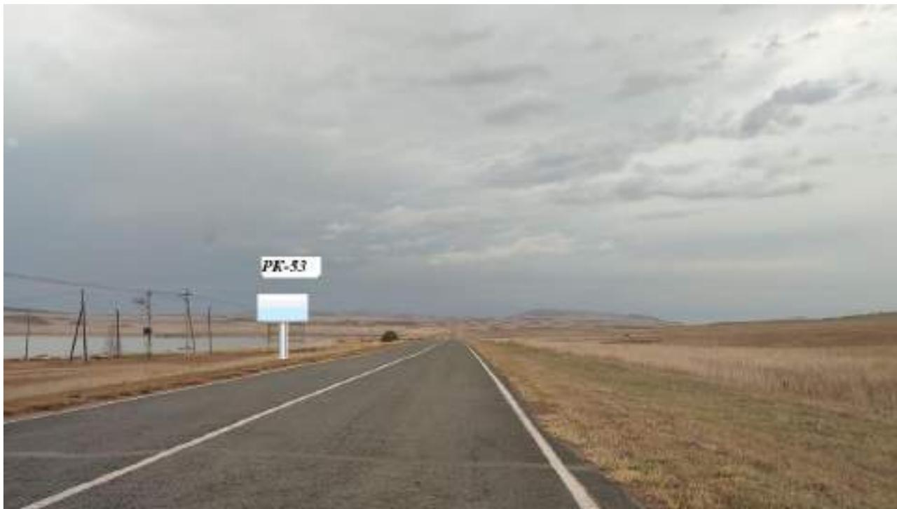
1. Расстояние сбоку от автомобильной дороги на расстоянии от бровки земляного полотна (внешней границы обочины) до ближайшей точки горизонтальной проекции внешнего конструктивного элемента средства наружной рекламы 14 м
