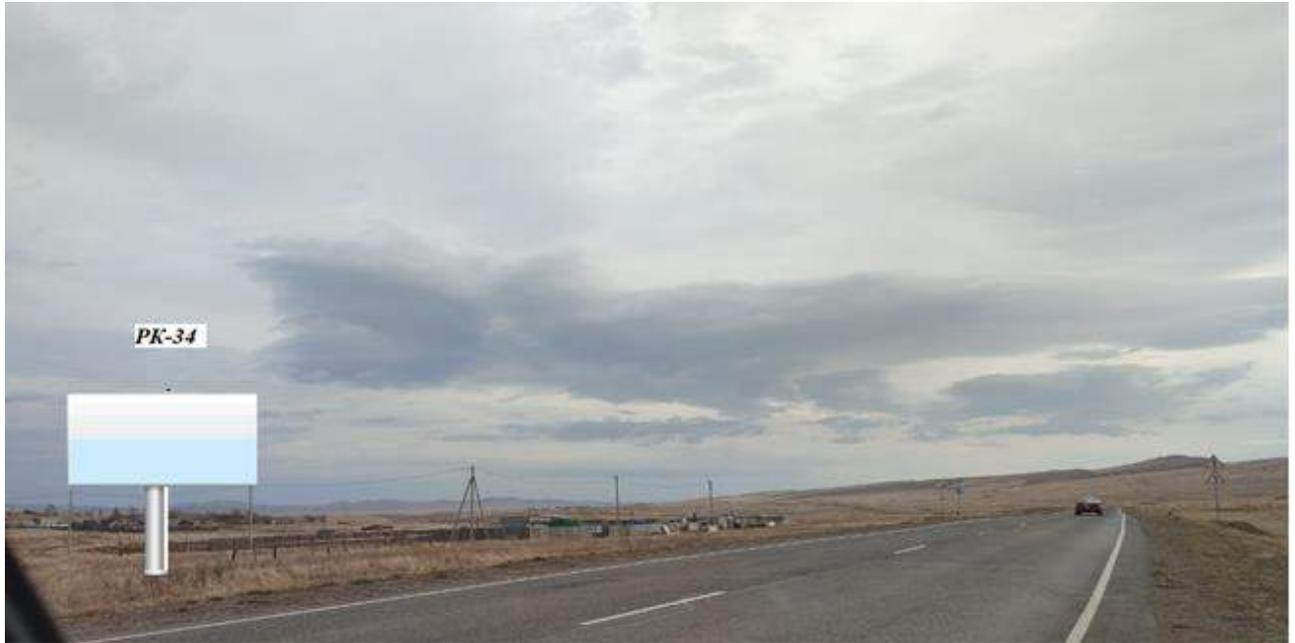
1. Расстояние сбоку от автомобильной дороги на расстоянии от бровки земляного полотна (внешней границы обочины) до ближайшей точки горизонтальной проекции внешнего конструктивного элемента средства наружной рекламы 12 м. Расстояние до перекрестка 350 м.
